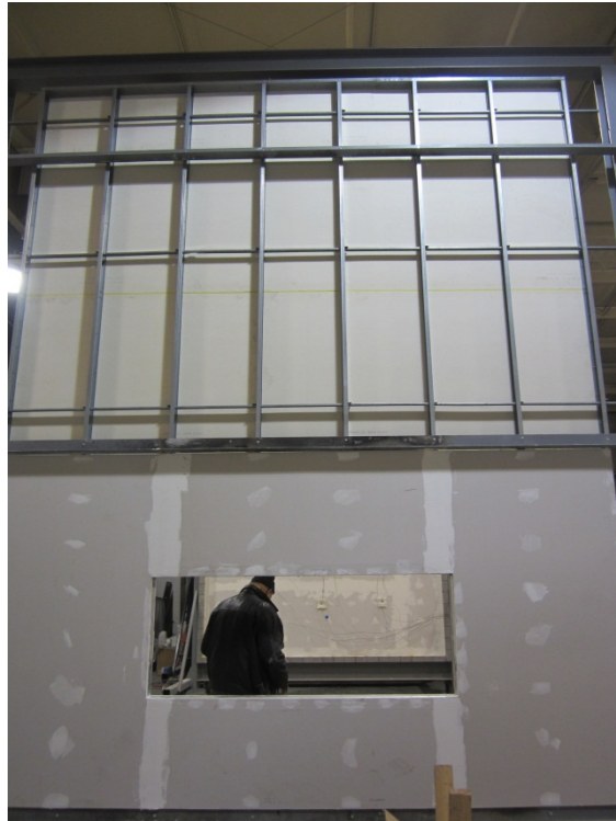
Photo No. 1 Stud Wall
